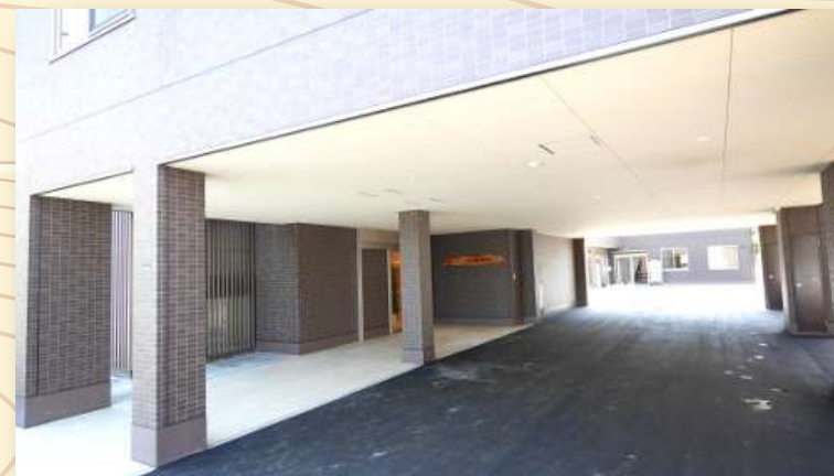
入口からの玄関への通路
